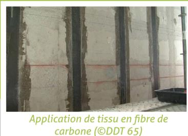
Application de tissu en fibre de carbone (©DDT 65)
