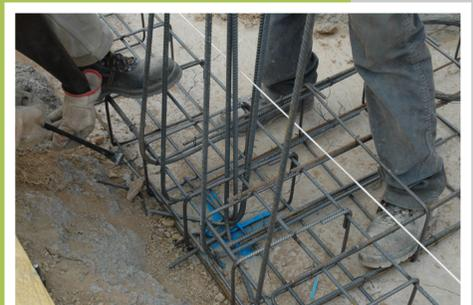
Mise en place du ferrailage d'une maison parasismique (©DDT 65)
