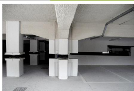
Renforcement d'un bâtiment par la mise en place d'amortisseurs parasismiques (©AFPS)
