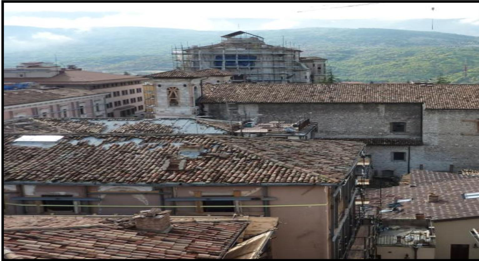
**(Rupture des fixations, déplacement important et destruction des tuiles, suites à des dommages importants à la structure en maçonnerie - Séisme d'Aquila 2009, Italie – Source Rapport de mission AFPS – P. PERROTIN)**
