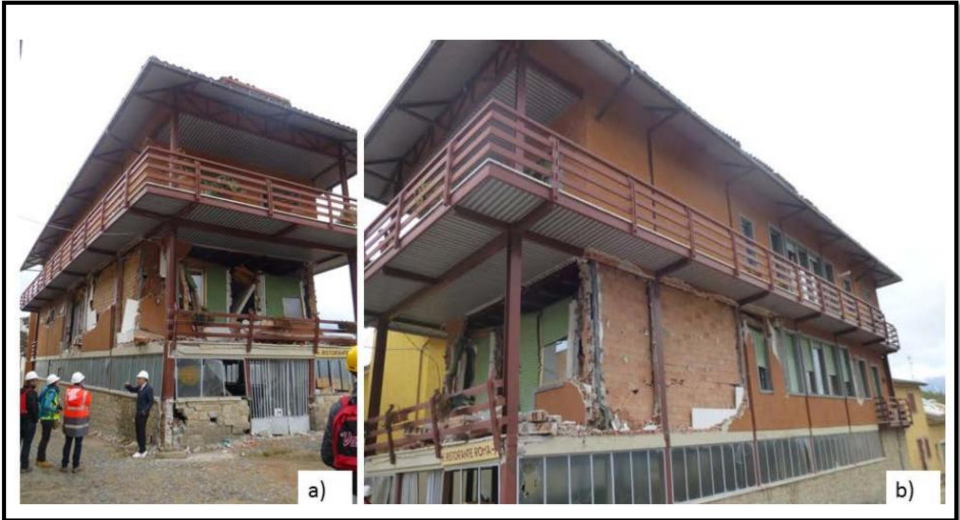
**(Dégâts dans les panneaux maçonnés du bâtiment en charpente métallique, Amatrice, Séisme 2016, Italie – Source Rapport de mission AFPS – A. BALGIU)**
