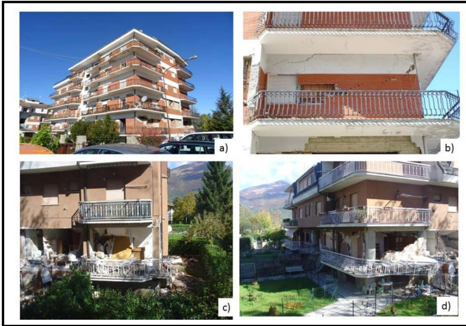
(Endommagement de remplissages en maçonnerie, Amatrice, Séisme 2016, Italie – Source Rapport de mission AFPS – A. BALGIU)
