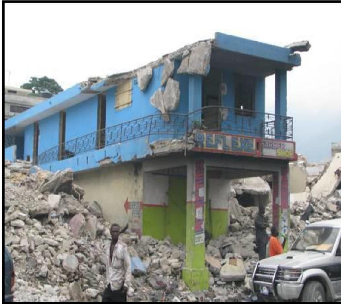
**(Chute des débords de toiture en béton en porte à faux - Séisme d'Haïti 2010 – Source Rapport de mission AFPS)**
