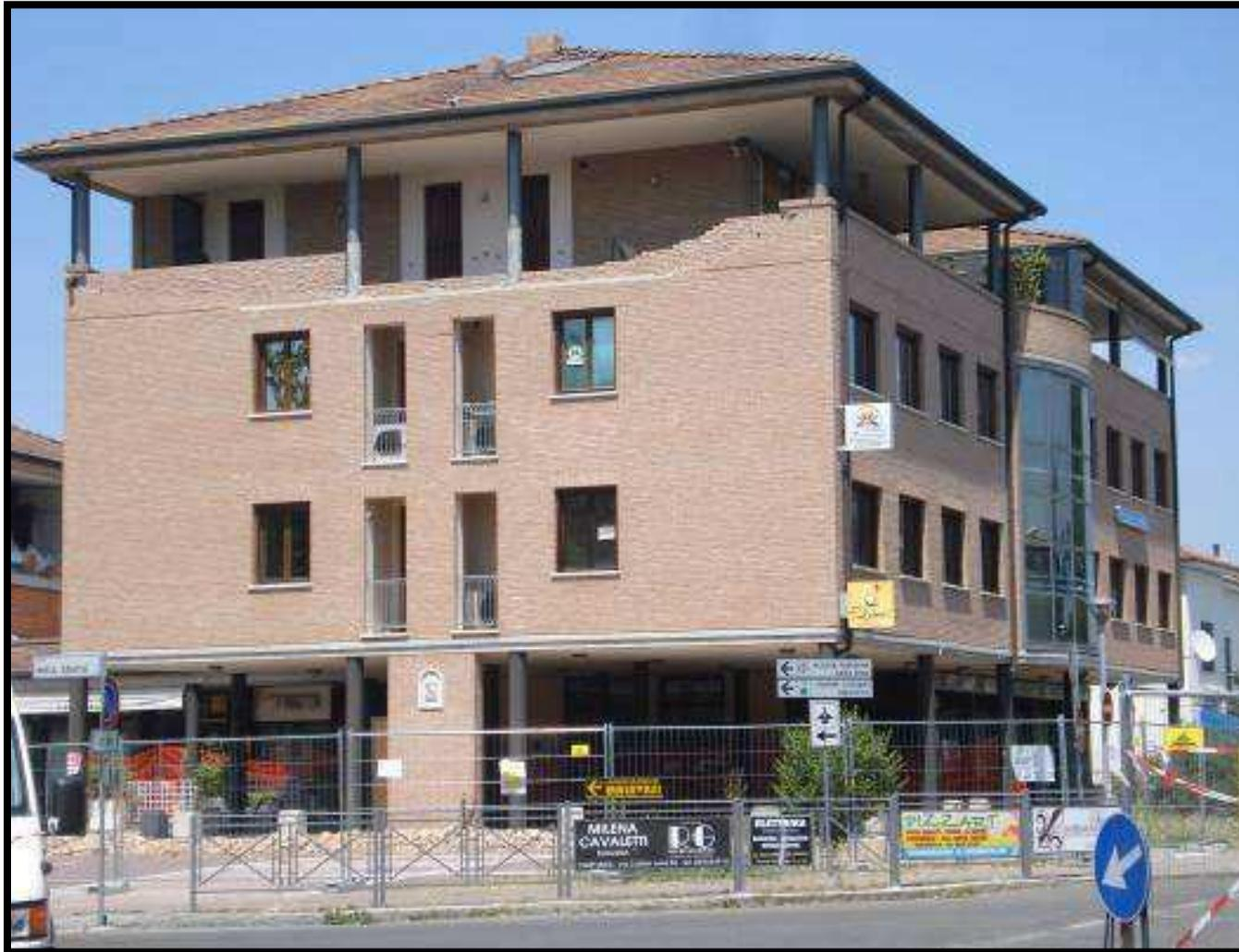
**(Chute de parapet au niveau d'une terrasse au dernier niveau - Séisme d'Emilie-Romagne 2012, Italie - Source Rapport de mission AFPS)**
