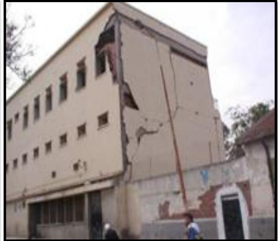
**(Destruction partielle des trumeaux et des panneaux de façade
