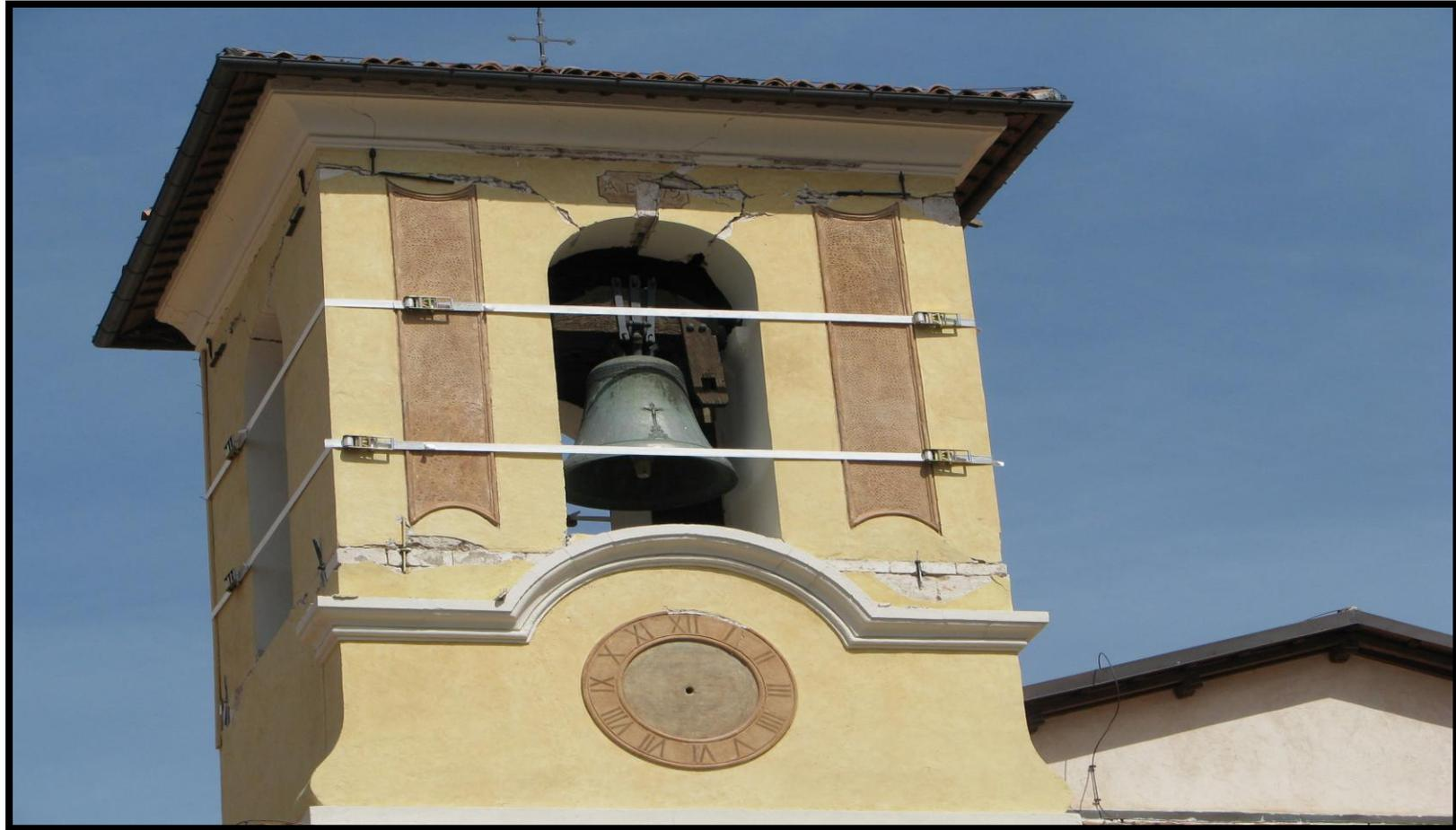
**(Fissures très importantes dans les maçonneries du clocher -
