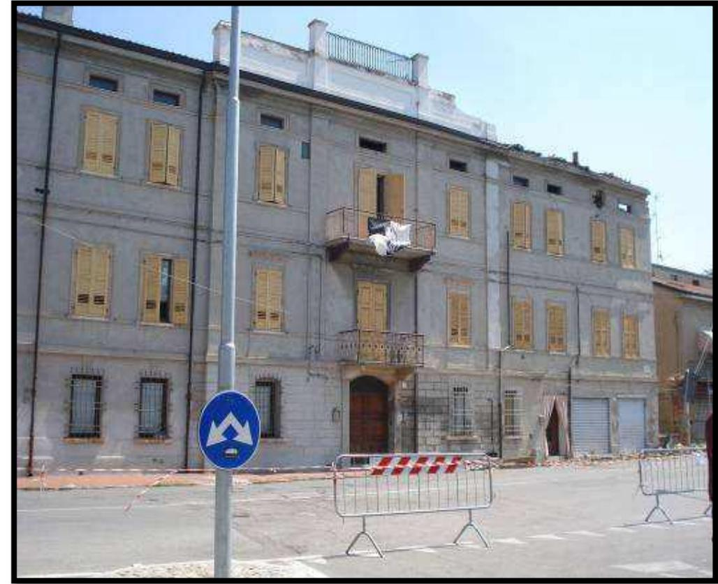
**(Endommagement et chute de parapet et fronton en maçonnerie - Séisme d'Emilie-Romagne 2012, Italie – Source Rapport de mission AFPS)**
