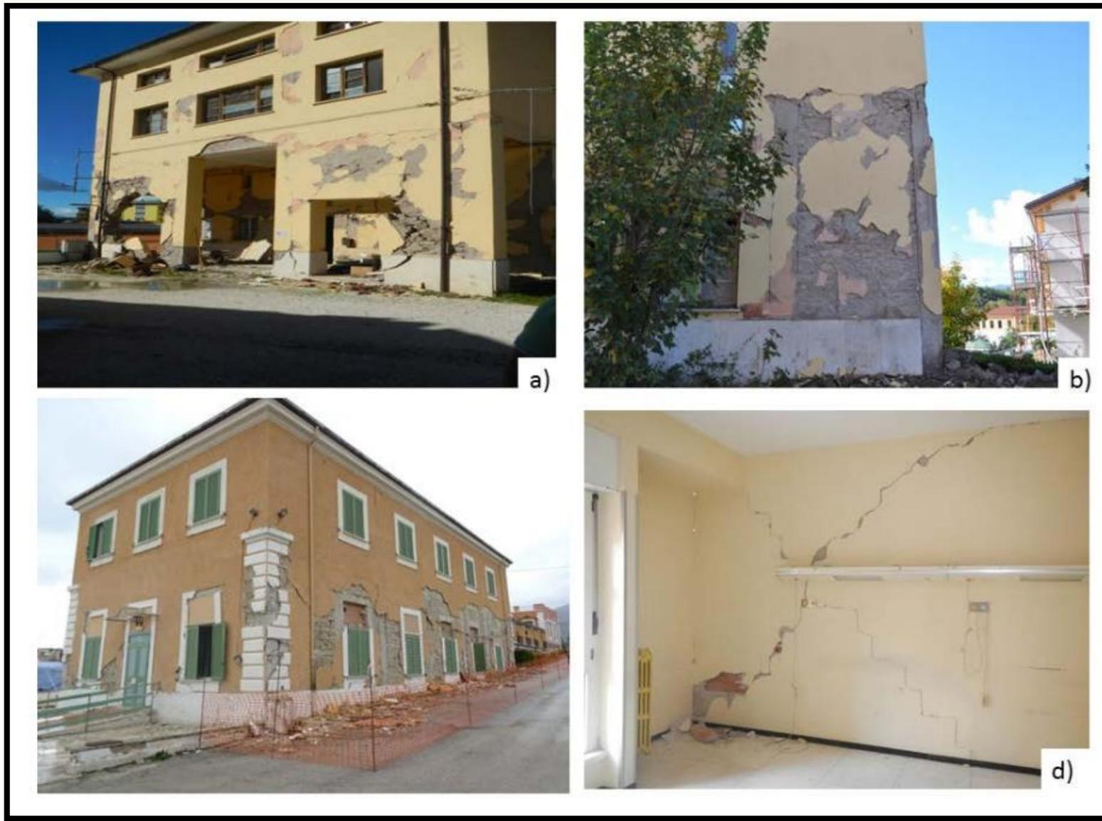
**(Endommagement de remplissages en maçonnerie, Amatrice, Séisme 2016, Italie – Source Rapport de mission AFPS – A. BALGIU)**
