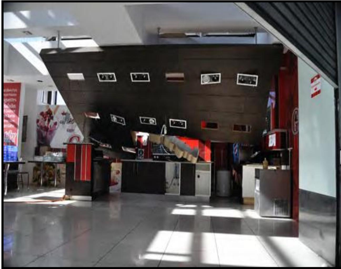
**(Chute plafond suspendu. Rupture des éléments de suspension –
