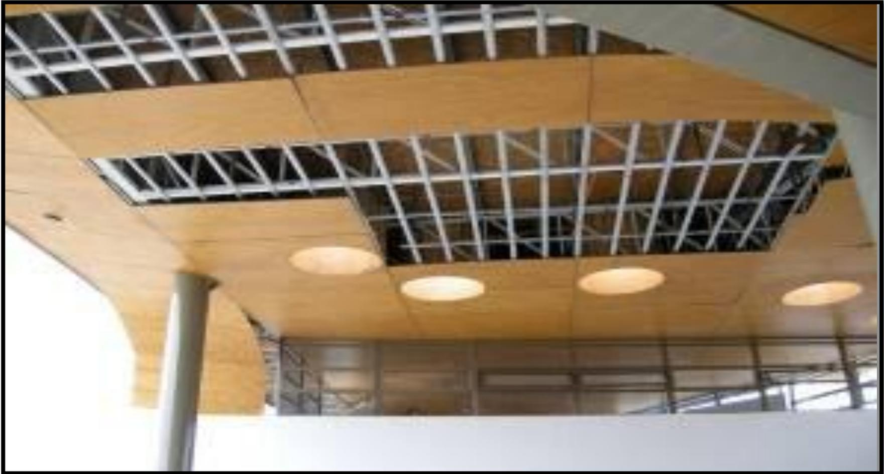
**(Chute partielle des panneaux de plafond en bois, suite à la perte des fixations à la structure du plafond suspendu – Séisme de Maule 2010, Chili – Source Rapport de mission AFPS)**
