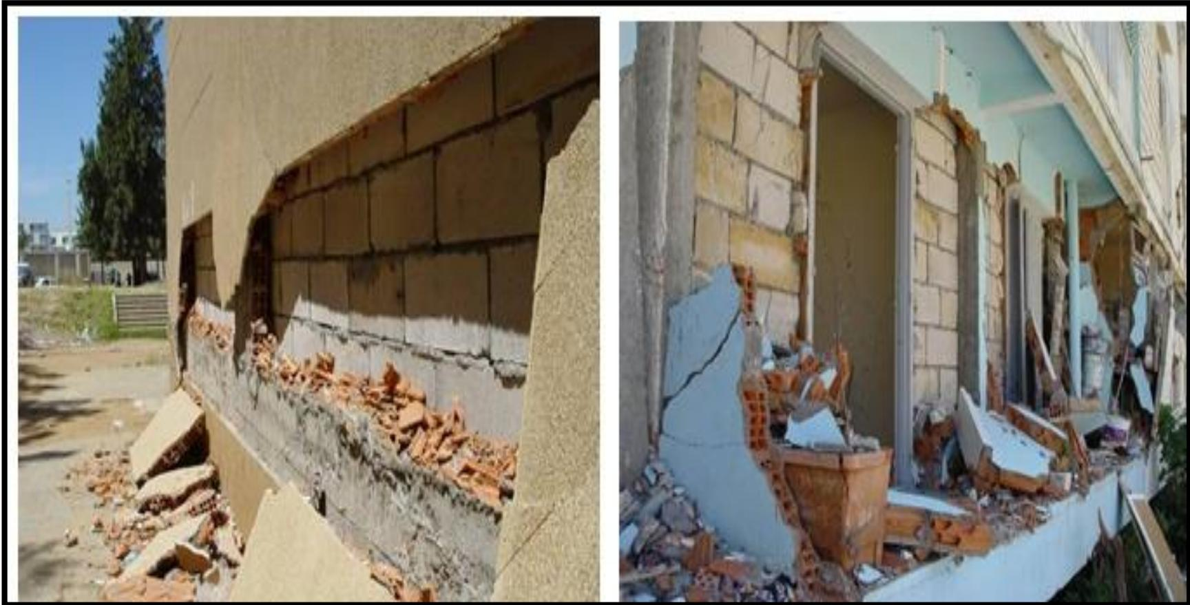
**(Damage étendu aux parements extérieurs en brique – Séisme de Boumerdès 2003, Algérie – Source Rapport de mission AFPS)**
