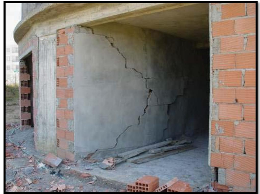
**(Fissures en “X” visibles dans la cloison du fond (photo gauche) et sur la cloison latérale (photo droite) - Séisme de Boumerdès 2003, Algérie - Source Rapport de mission AFPS)**
