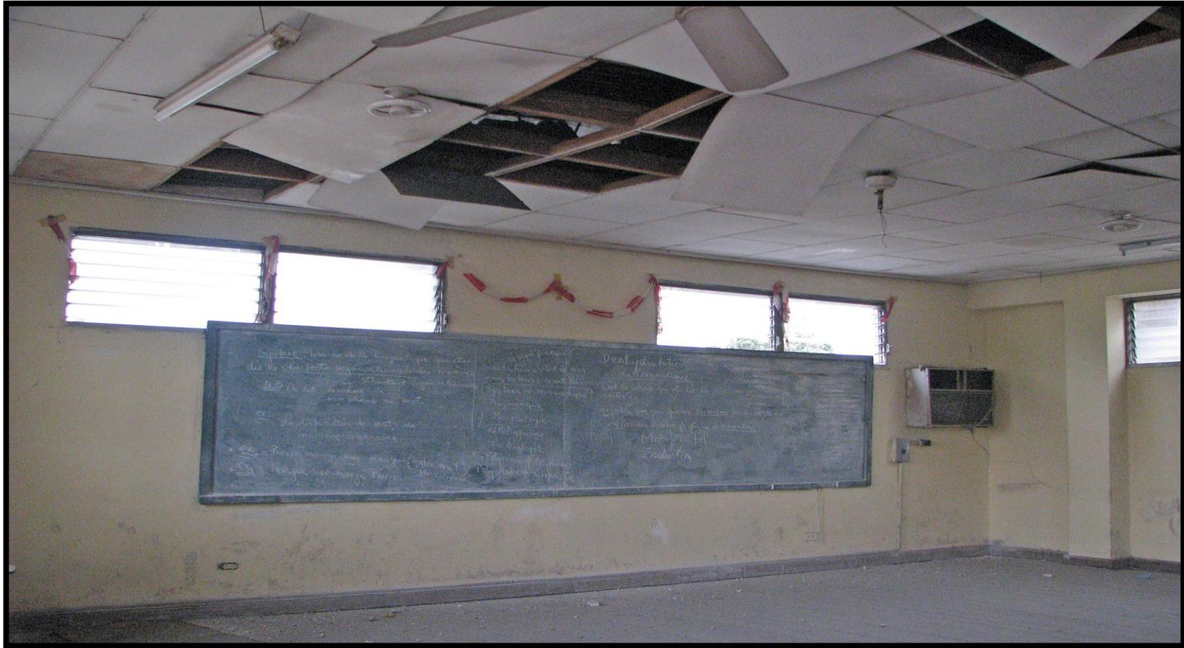
**(Chute des faux plafonds en plaques de bois clouées sur une structure porteuse en bois - Séisme d'Haïti 2010 – Source Rapport de mission AFPS – F. DUNAND)**
