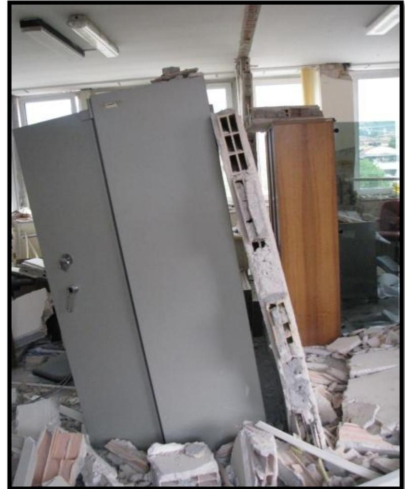
**(Chute des cloisons en maçonnerie - Séisme d'Aquila 2009, Italie
