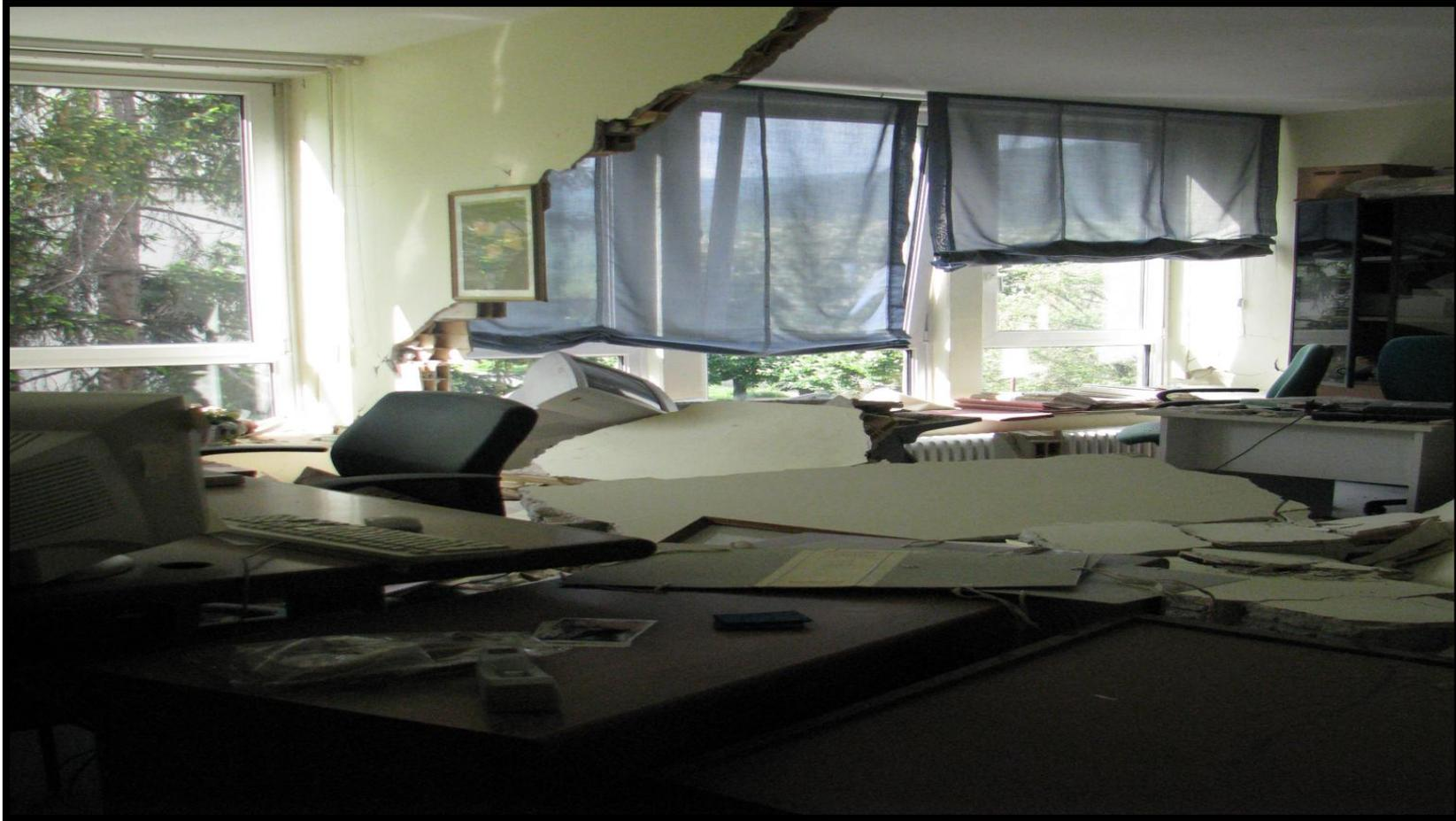
**(Chute des cloisons en maçonnerie - Séisme d'Aquila 2009, Italie
