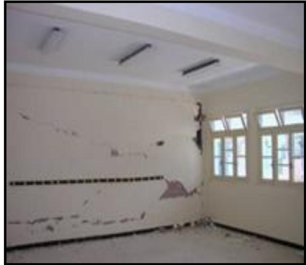
**(Eclatement et fissuration de cloisons en maçonnerie – Source AFPS)**
