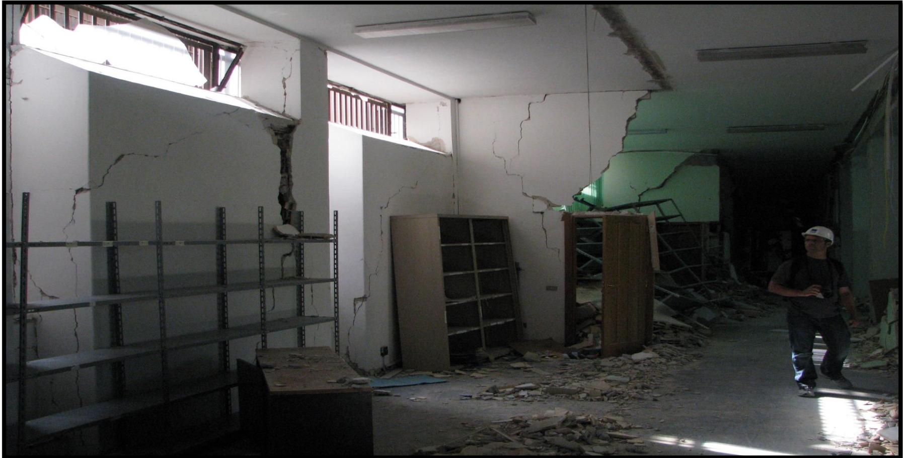
**(Chute des cloisons en maçonnerie - Séisme d'Aquila 2009, Italie
