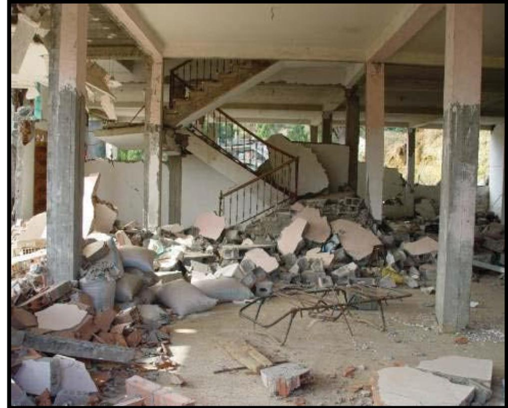
**(Destruction complète des cloisons, sans conséquences pour les poteaux, suite à une déformation importante de la structure - Séisme de Boumerdès 2003, Algérie – Source Rapport de mission AFPS)**
