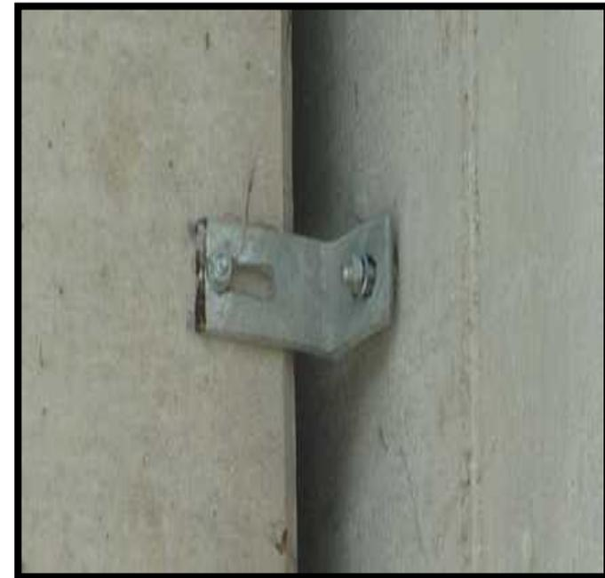
**(Chute des éléments de façade lourds. Cause : liaisons d'éléments de façade sous-dimensionnés – Séisme d'Emilie-Romagne 2011, Italie – Source Rapport de mission AFPS)**
