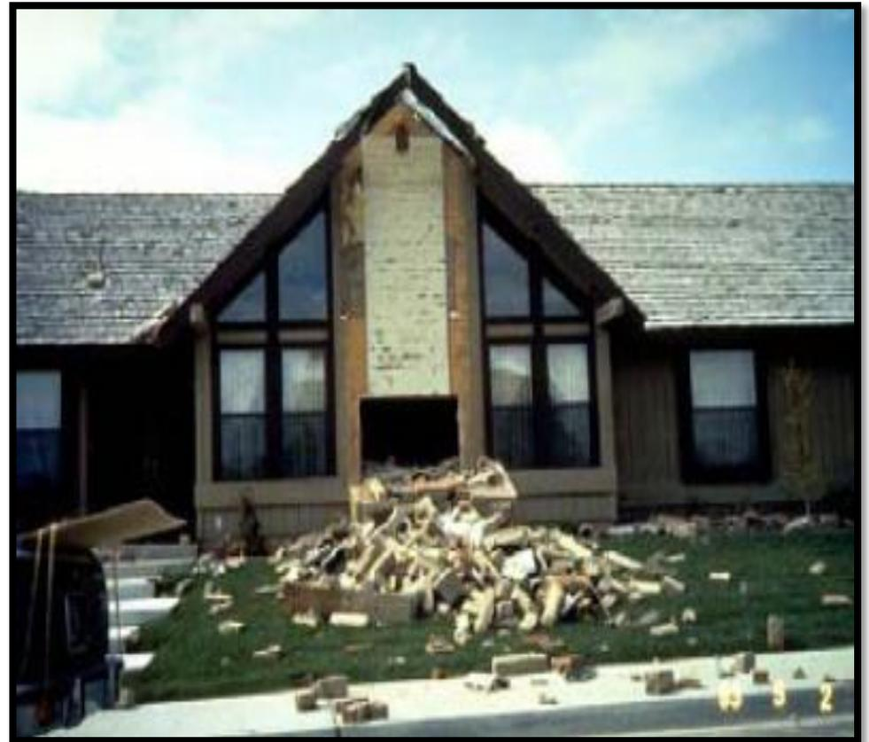
**(Rupture des fixations de la cheminée extérieure - Défaut d'ancrage des cheminées - Source M. ZACEK)**
