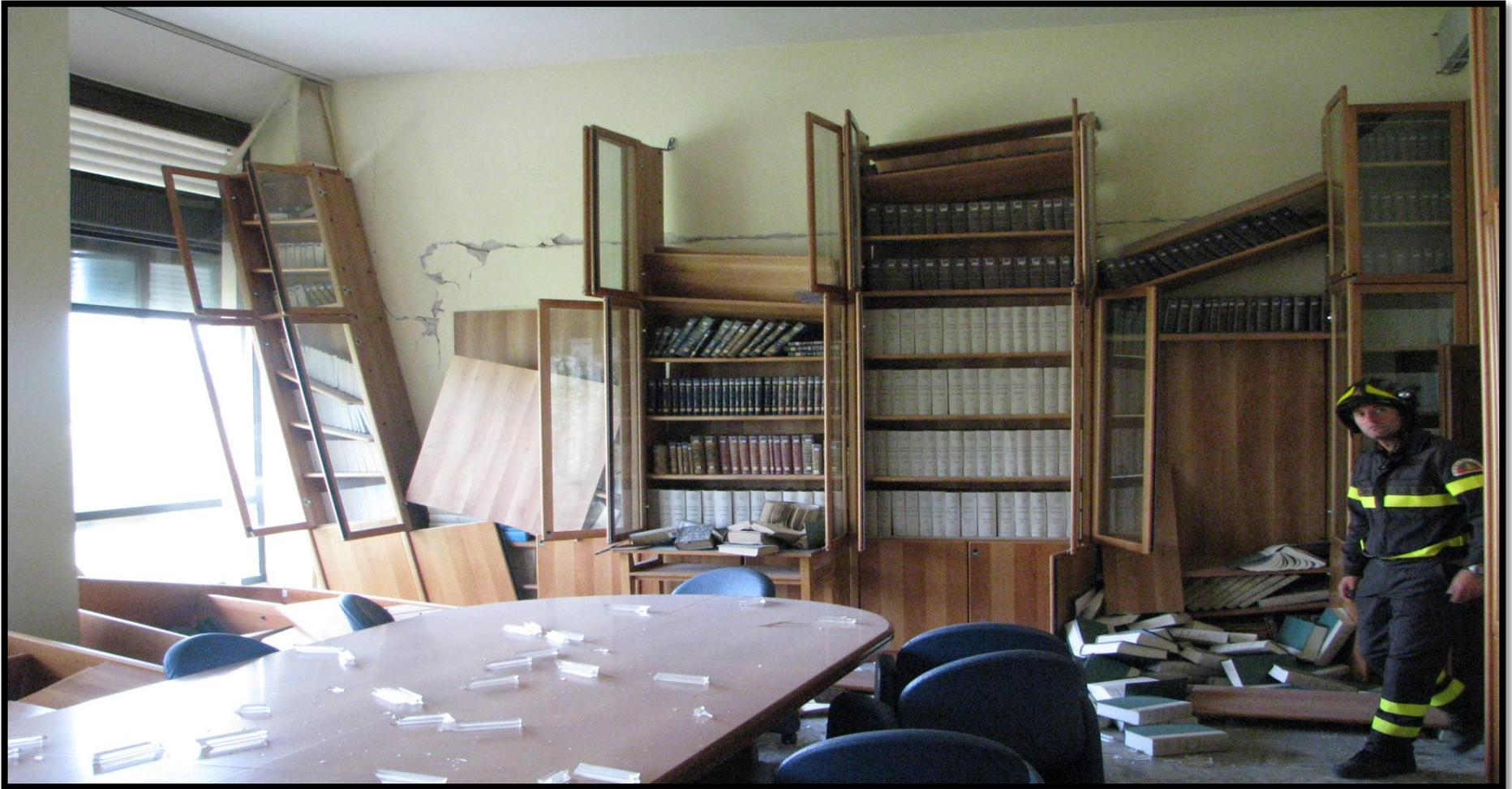
**(Fissures très importantes dans les cloisons en maçonnerie - Séisme d'Aquila 2009, Italie – Source Rapport de mission AFPS – F. DUNAND )**
