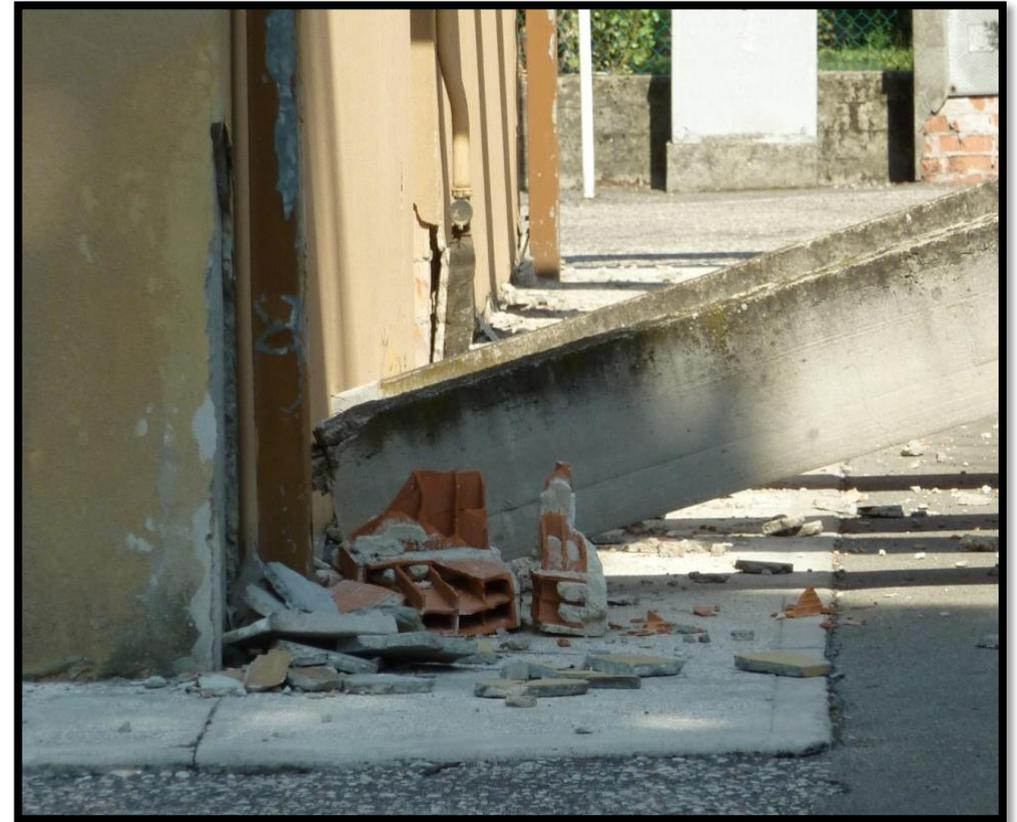
**(Perte de support des poutres brise-soleil béton, faiblement encastées dans le mur – Séisme d’Emilie-Romagne 2012, Italie – Source - Rapport de mission AFPS – P. PERROTIN )**
