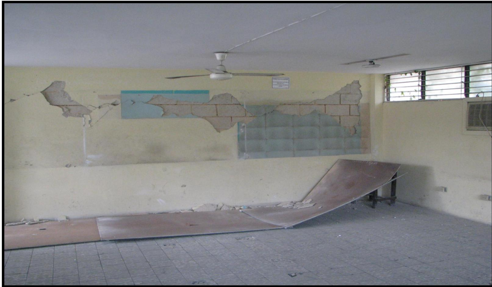
**(Fissures assez importantes dans un mur intérieur en maçonnerie
