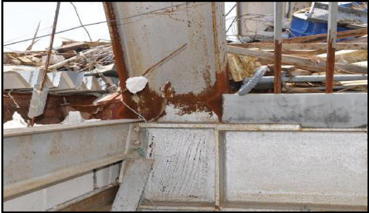
**Flambement de poteau sous l'effet d'un moment hors plan
