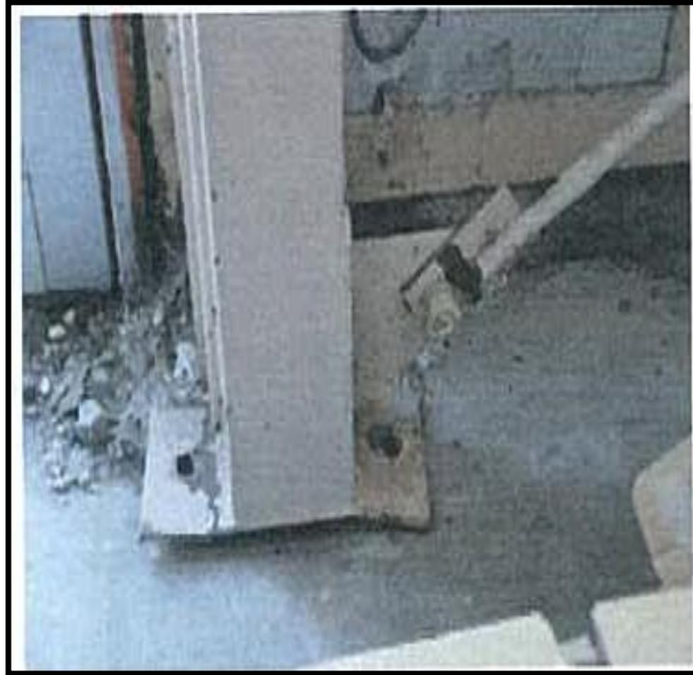
**Rupture des tiges d'ancrage des poteaux métalliques, dans les massifs de fondations (Myagino, Sendai – Séisme de Tohoku 2011, Japon – Source Rapport Université de Hokkaido)**
