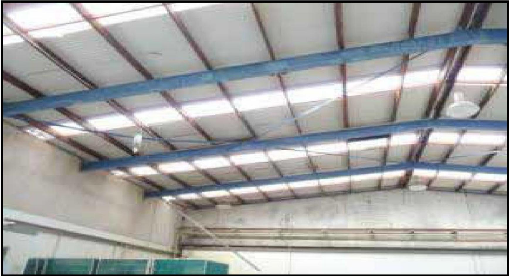
(Une diagonale flambée et une autre brisée, dans la poutre au vent toiture - Séisme de Christchurch 2011–Source Rapport Université de Canterbury, Nouvelle-Zélande)
