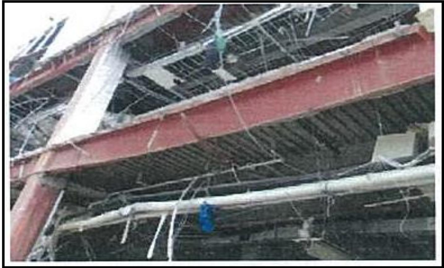
**Déformation par torsion et déversement d'une poutre métallique de plancher (Sendai – Séisme de Tohoku 2011, Japon – Source Rapport Université de Hokkaido)**
