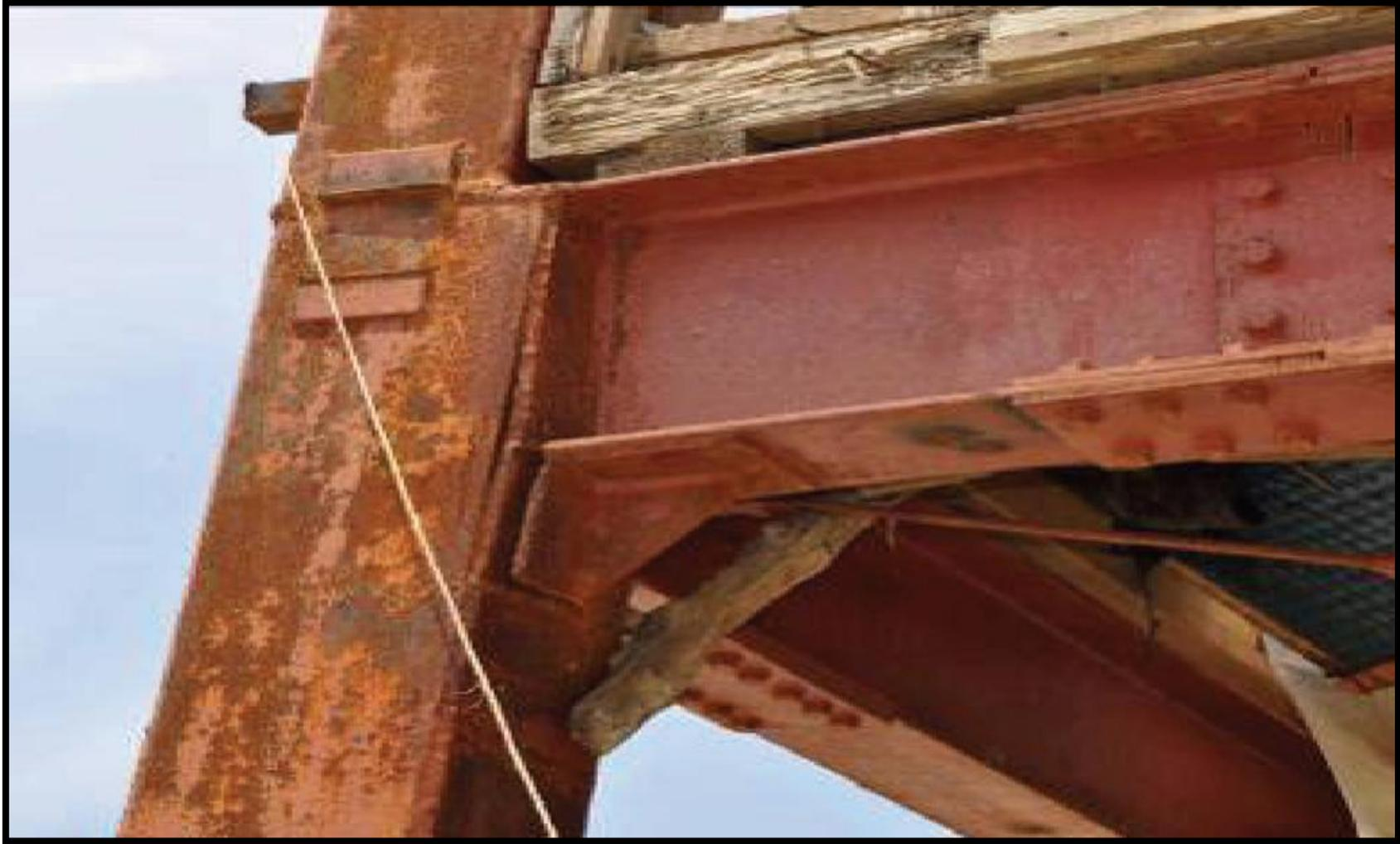
**(Rupture d'un cordon de soudure dans un assemblage poteau-poutre – Séisme de Tohoku 2011, Japon - Source Rapport mission AFPS)**
