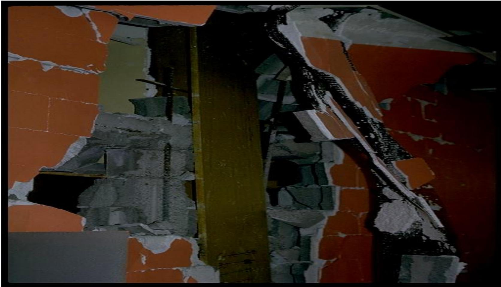
(Remplissages en maçonnerie armée détruits par les déformations trop importantes de l'ossature métallique)
