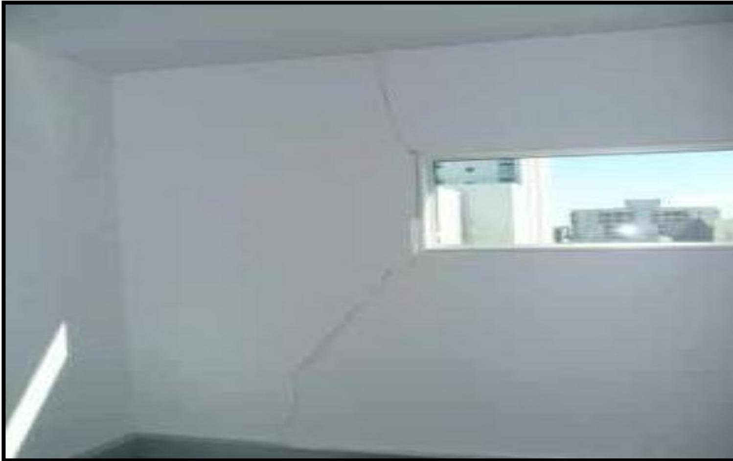
**Fissuration d'un mur de remplissage
