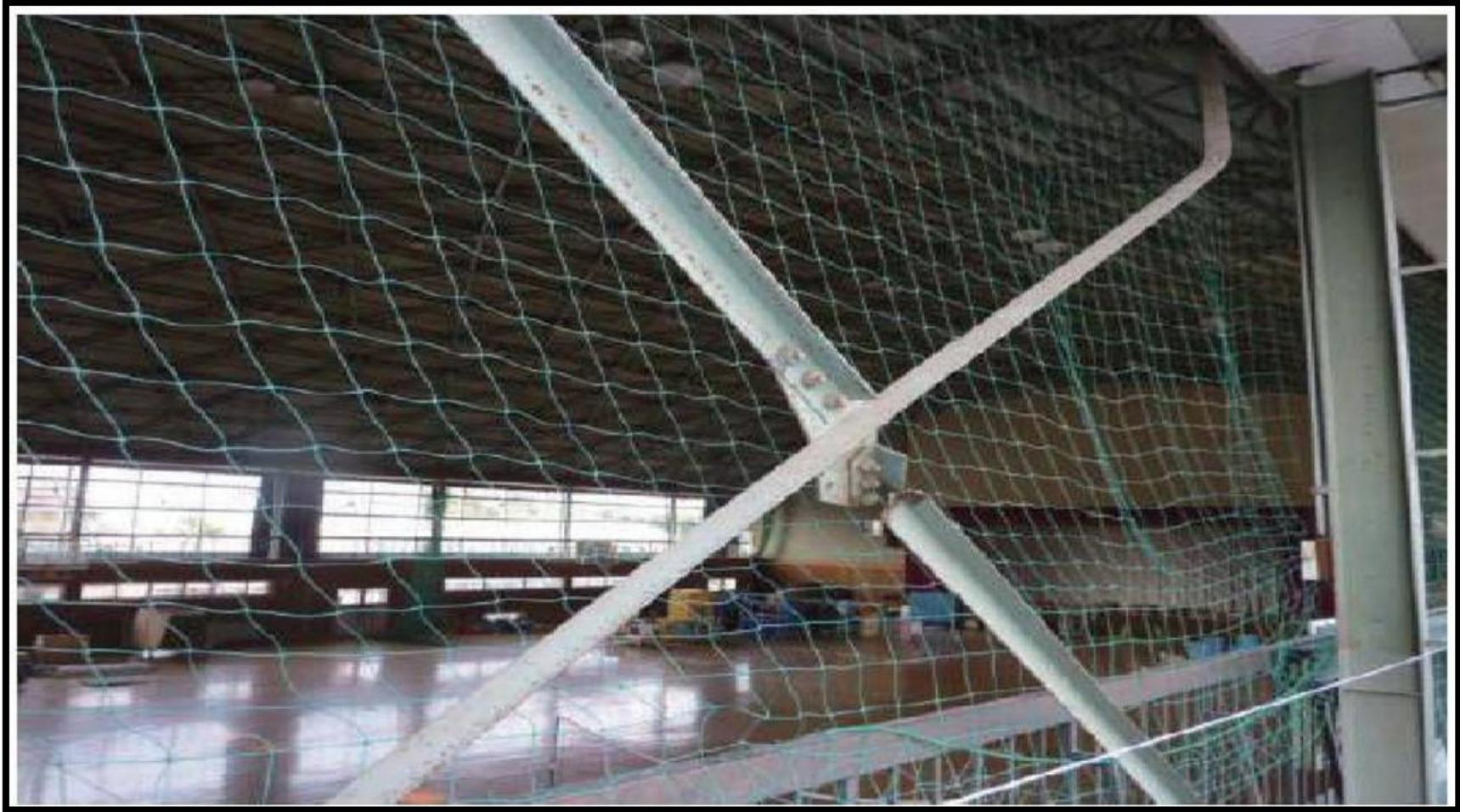
**(Flambement d'une des diagonales et rupture en traction en section nette de l'autre, au droit du gousset central - stabilité à barres centrées – Séisme de Tohoku 2011, Japon - Source Rapport mission AFPS)**
