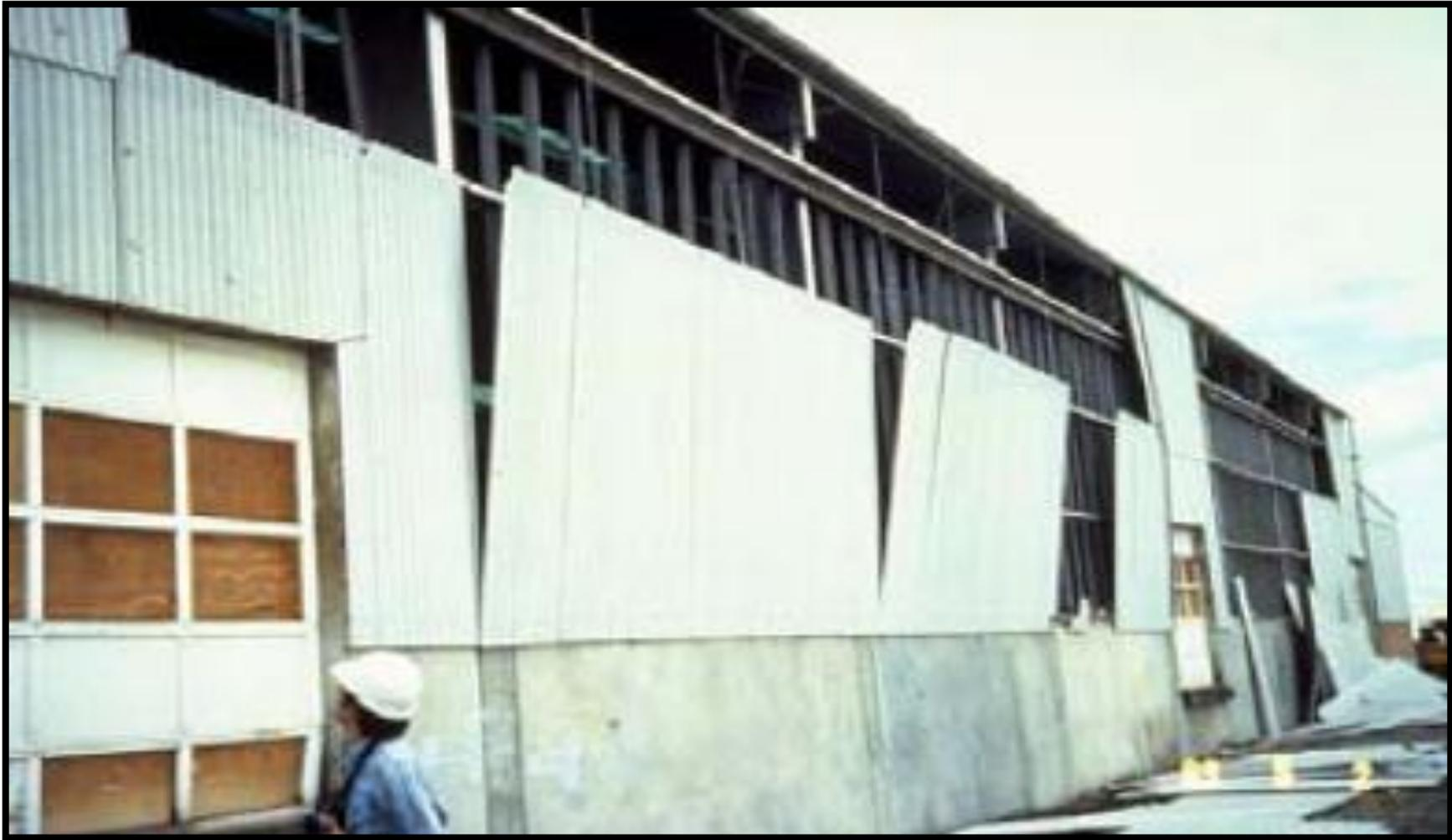
**(Dégâts importants sur le bardage métallique des long-pans – Séisme de Coalinga 1983, Etats-Unis - Source Milan Zacek)**
