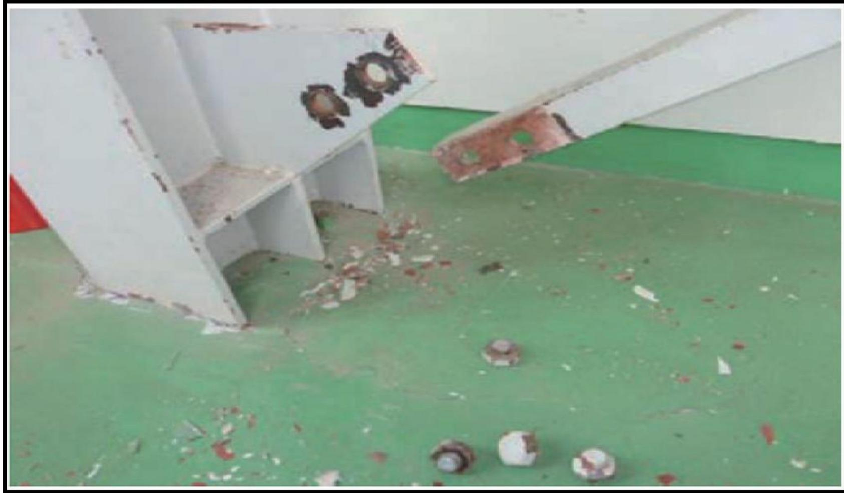
**(Rupture fragile de l'assemblage par cisaillement des boulons - stabilité à barres centrées – Séisme de Tohoku 2011, Japon - Source Rapport mission AFPS)**
