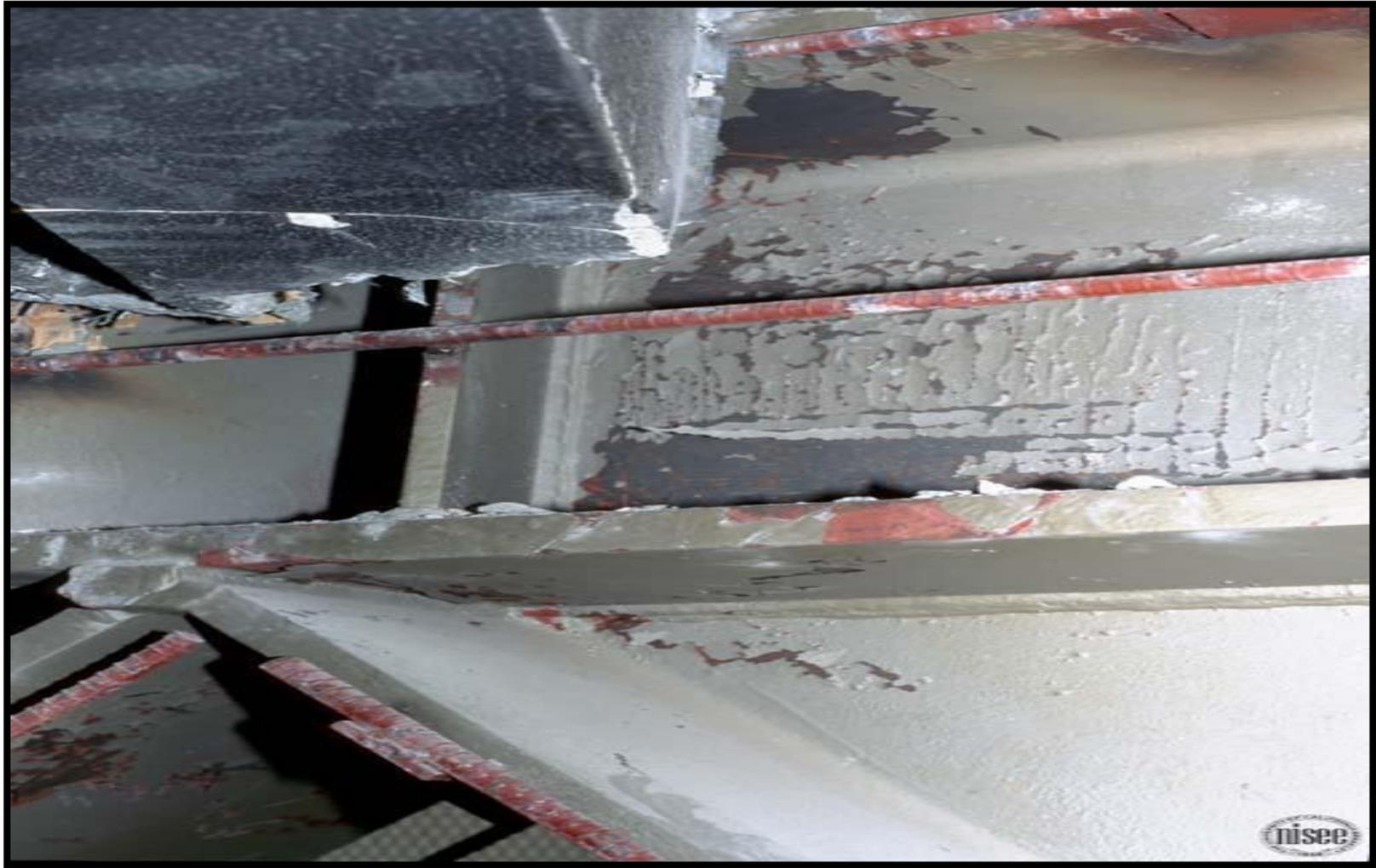
(Traces de plastification locale dans un assemblage – Séisme de Kobe 1995, Japon – Source Nisee)
