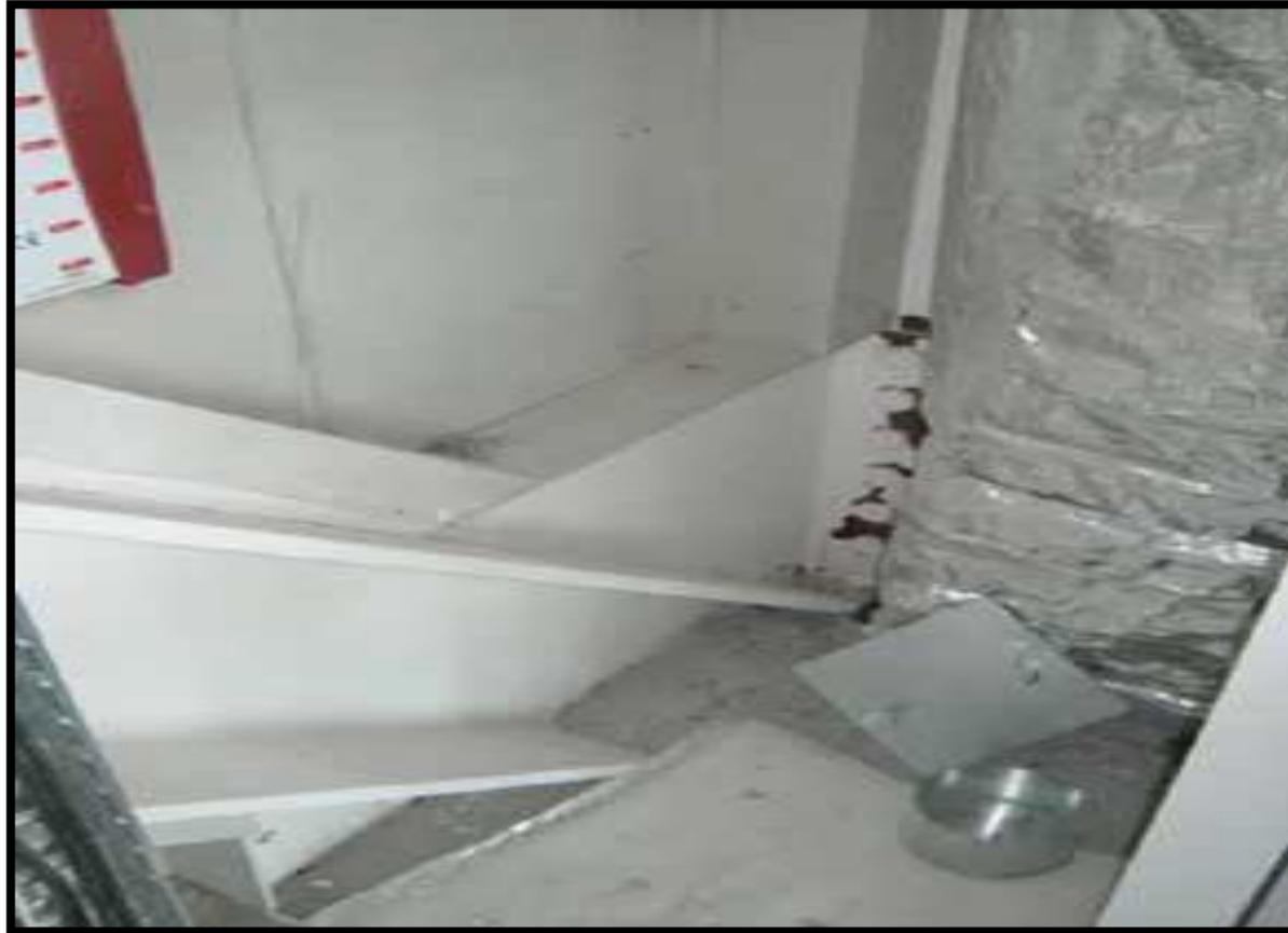
**Assemblage diagonale / poutre / poteau, montrant une plastification sous flexion hors plan de la platine d'extrémité, mais pas de plastification du gousset (Assemblage dans l'immeuble « Club Tower » - Séisme de Christchurch 2011 – Source Rapport Université de Canterbury, Nouvelle-Zélande)**
