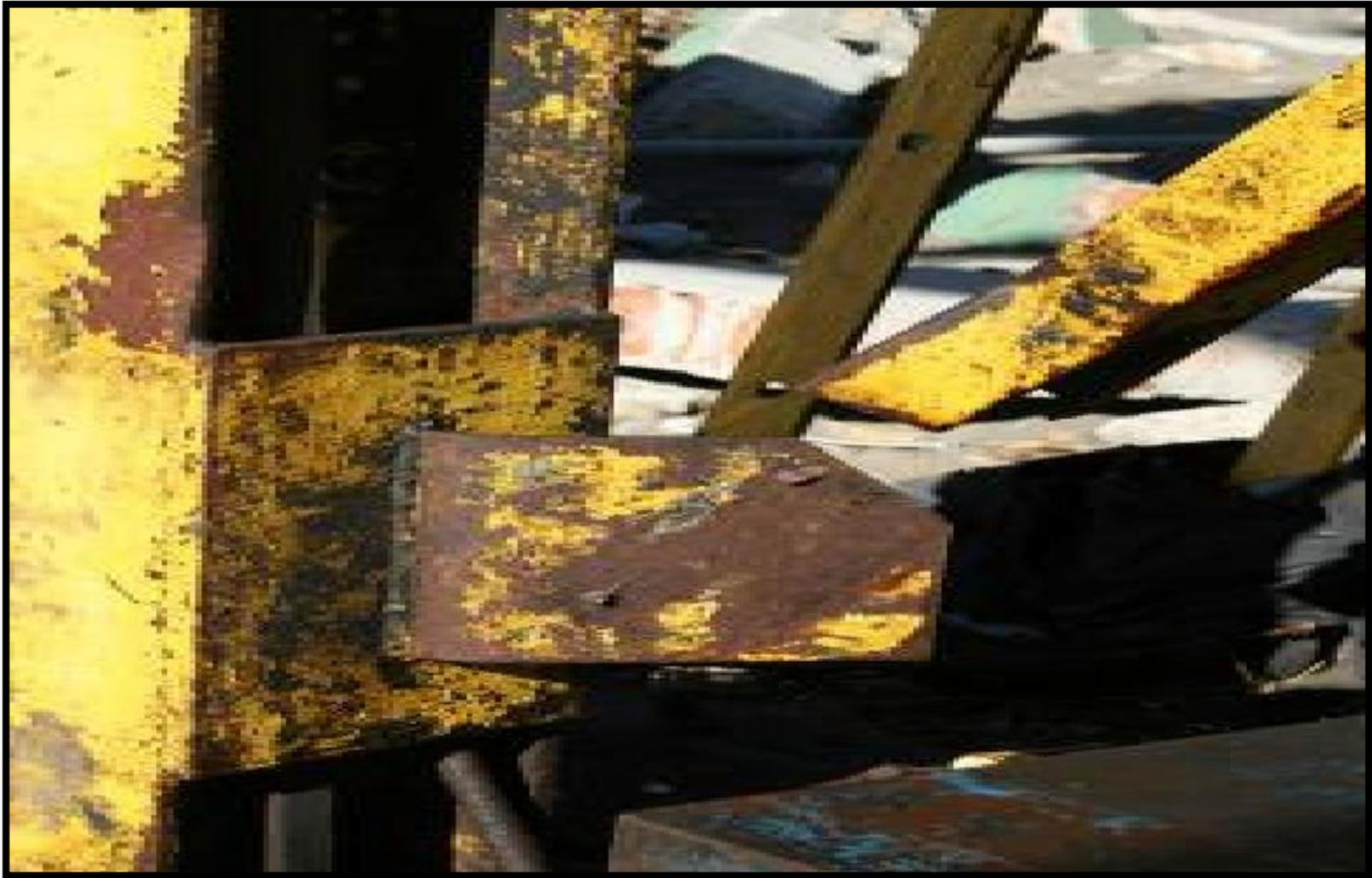
**(Rupture d'une diagonale tubulaire - stabilité à barres centrées – Scierie de Constitucion - Séisme du Chili 2010 - Source Rapport mission AFPS)**
