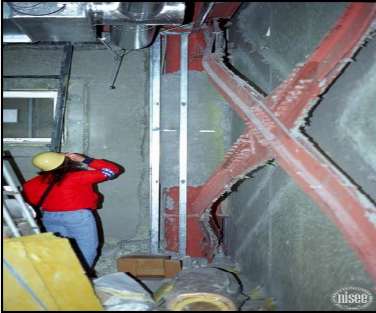
(Flambement des diagonales d'une stabilité à barres centrées
