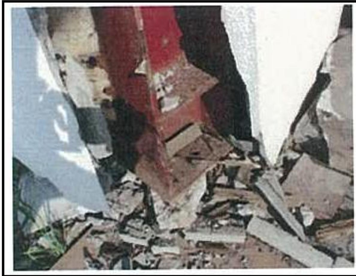
**Rupture des tiges d'ancrage des poteaux métalliques, dans les massifs de fondations (Myagino, Sendai – Séisme de Tohoku 2011, Japon – Source Rapport Université de Hokkaido)**
