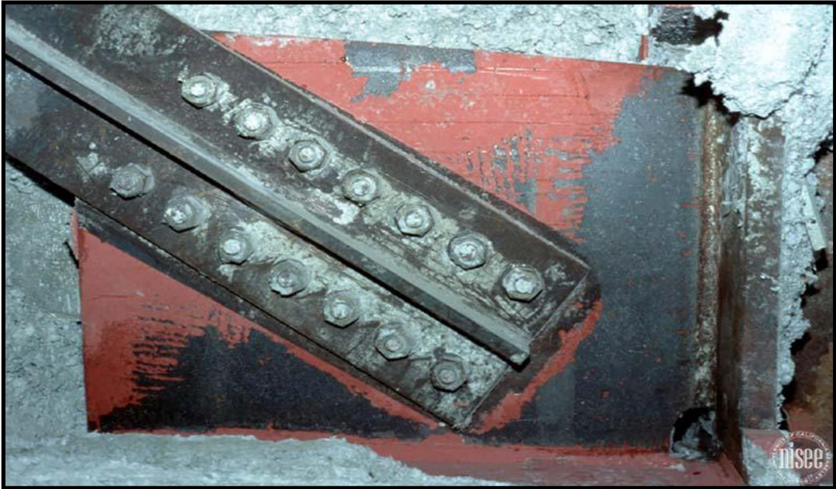
(Traces de plastification dans le gousset d'une stabilité à barres centrées
