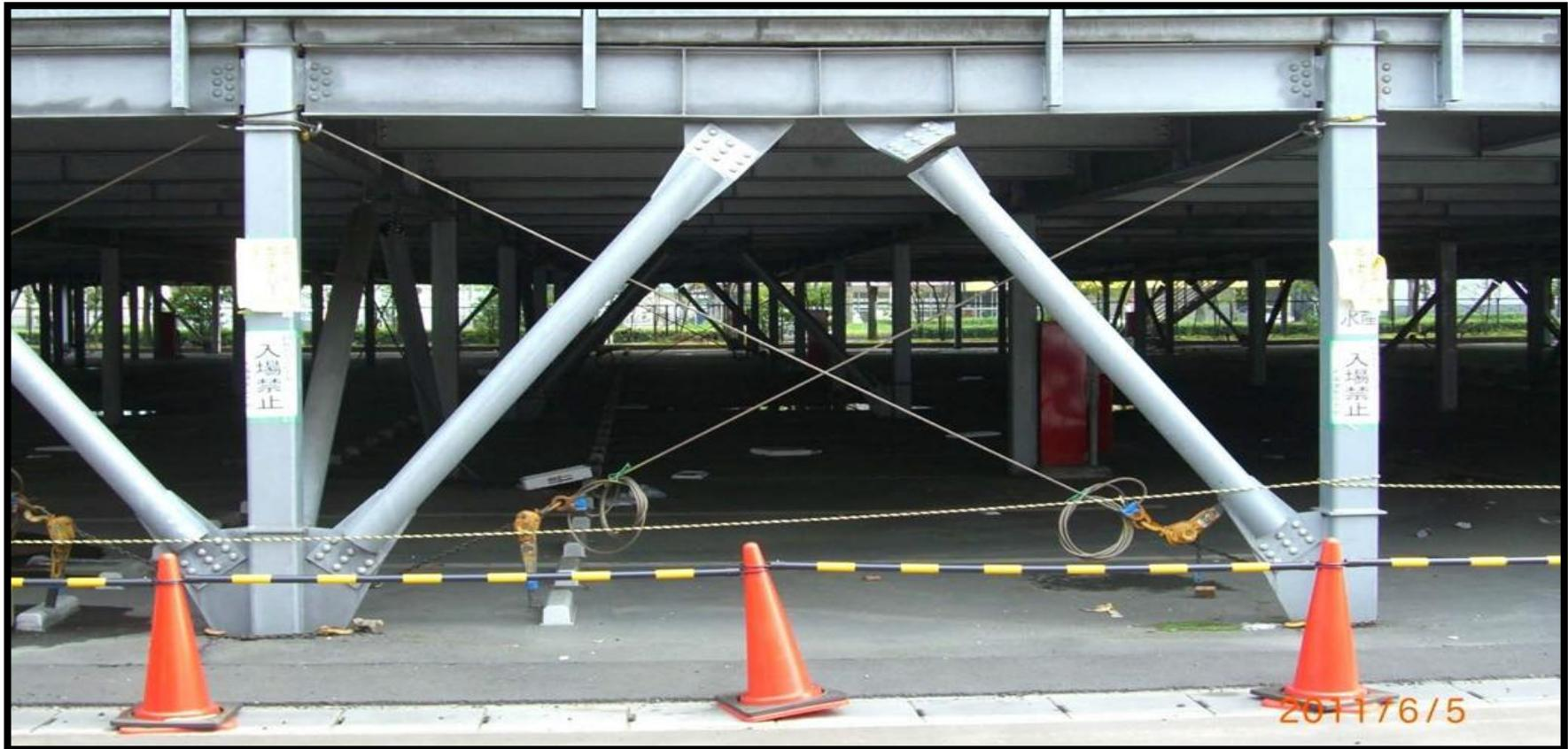
**Déformation hors plan et rupture du gousset d'une des diagonales d'une stabilité verticale (Parking Sendai – Séisme de Tohoku 2011, Japon – Source Rapport Université de Hokkaido)**
