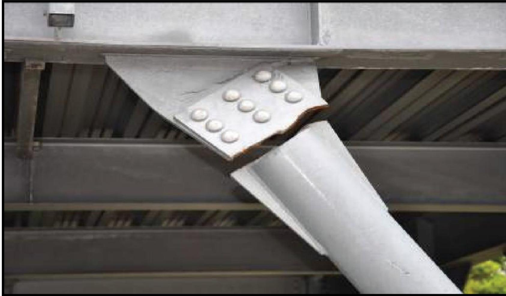
(Détail de rupture d'un gousset - stabilité à barres centrées – Séisme de Tohoku 2011, Japon - Source Rapport mission AFPS)
