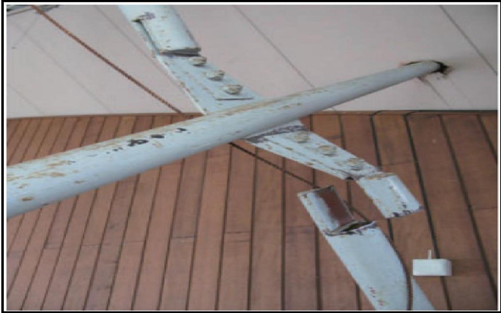
**(Rupture d'assemblage de tube sur gousset au croisement des diagonales - stabilité à barres centrées – Séisme de Tohoku 2011, Japon - Source Rapport mission AFPS)**
