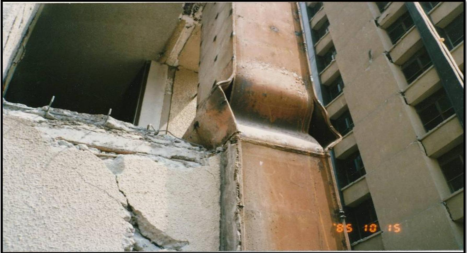
(Flambement local d'un poteau d'une tour à structure métallique –
