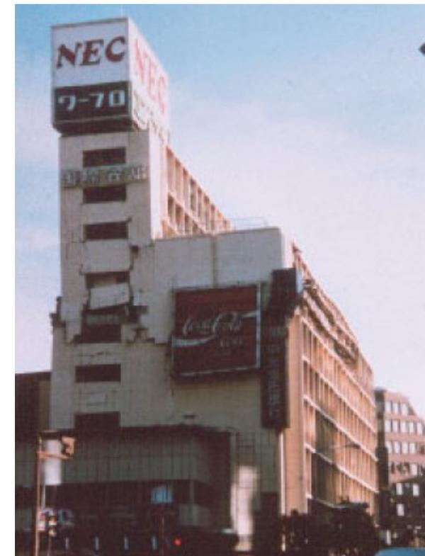
b) Bâtiment endommagé par le séisme de Kobé, Japon (17.1.1995). La partie supérieure du bâtiment n'oscille pas à la même fréquence que sa partie inférieure
