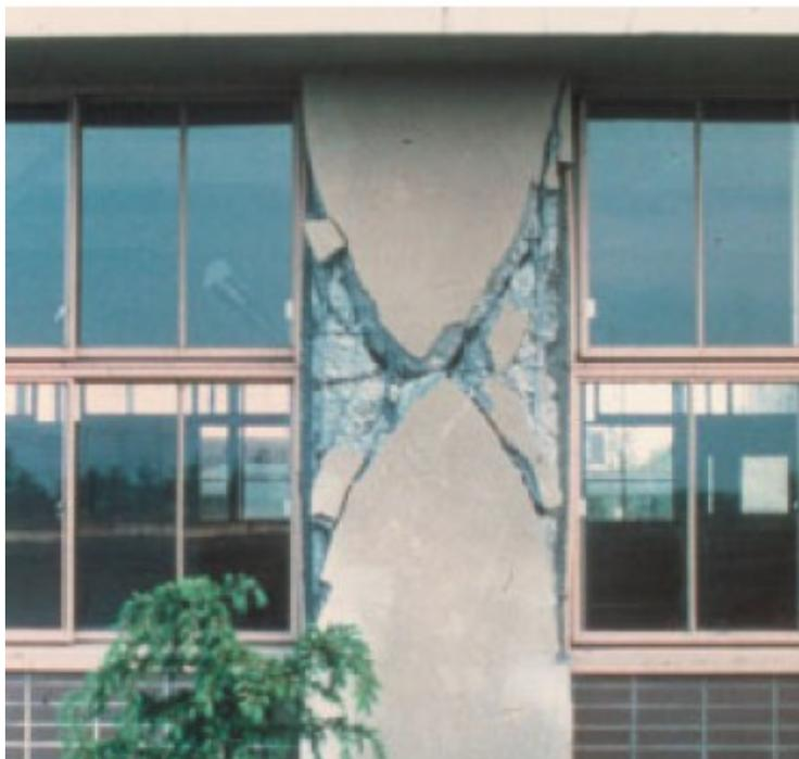
Poteau bridé d'un seul côté : une seule fissure en diagonale correspondant à la déformation du poteau vers l'allège
