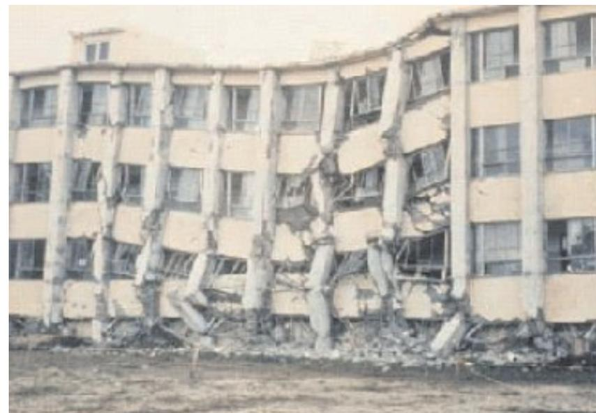
Si le contreventement n'est pas assuré par les portiques mais par des voiles en béton armé, le principe de poteaux forts poutres faibles n'est pas impératif car les rotules plastiques se formeront dans les voiles bien plus rigides
