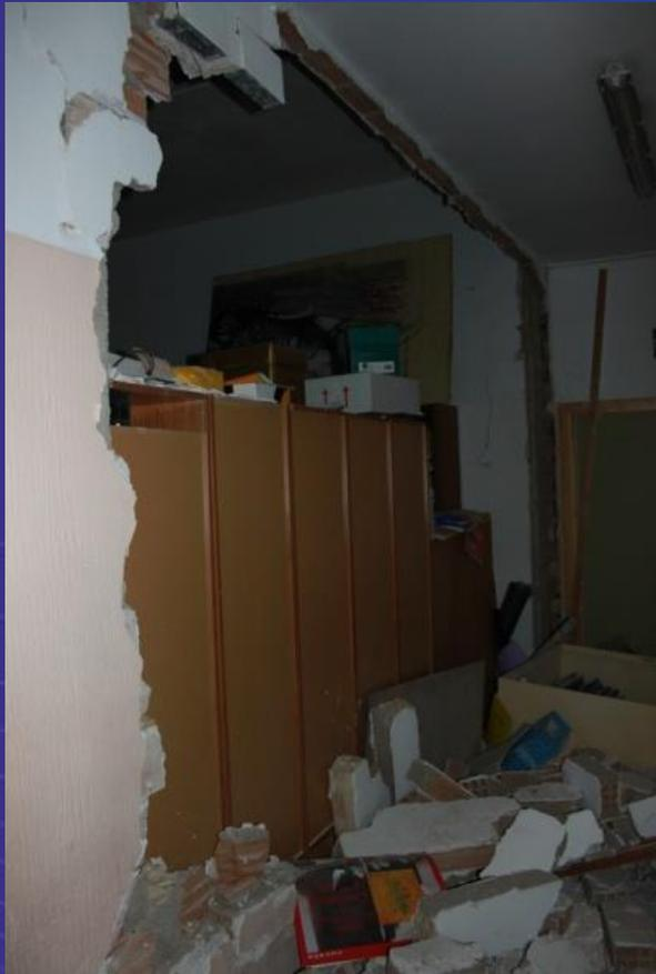
Rupture hors-plan au rez-de-chaussée d'un collège à proximité de la sortie
