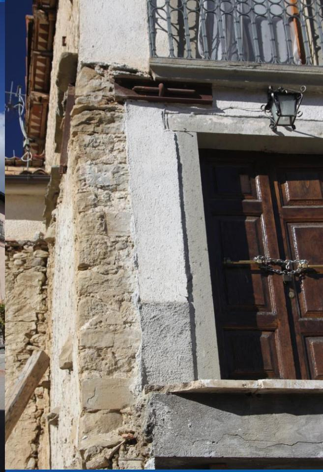
Confortement par tirants horizontaux: Bâti rural avec quelques traces de confortements sismiques à quelques kilomètres d'Amatrice et à Pescara del Tronto
