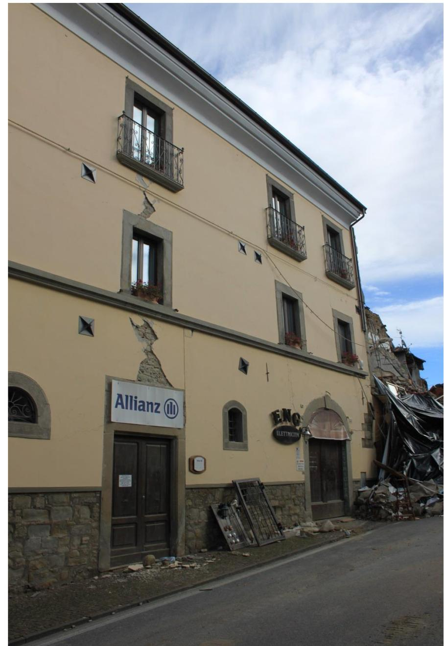
Bâtiment en maçonnerie R+2 ayant subi un confortement sismique (Amatrice - Corso Umberto)
