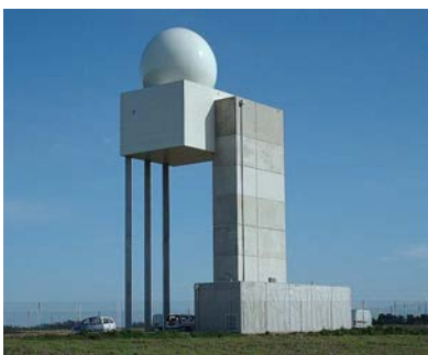
Radar Météo France de Momuy- Landes
